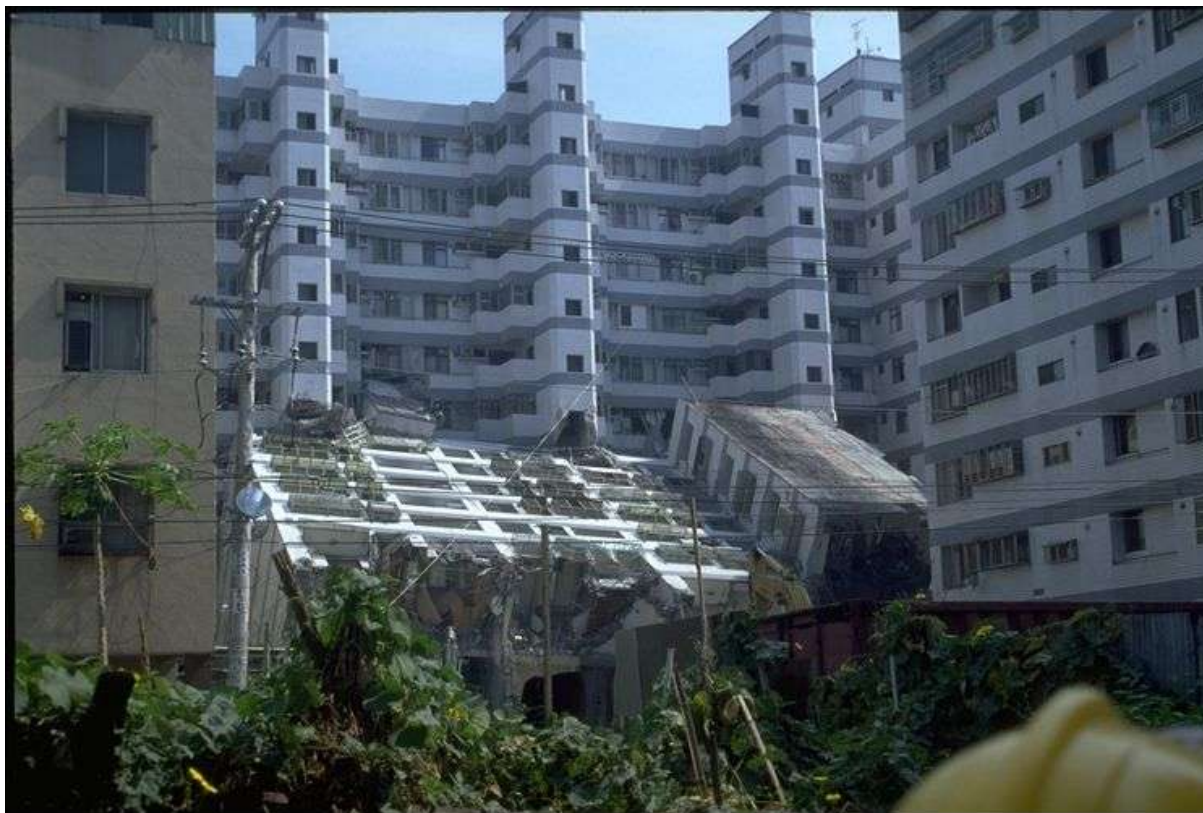
地震造成之房屋建築整棟傾倒災變照片 (土木工程技術地震叢書I)
