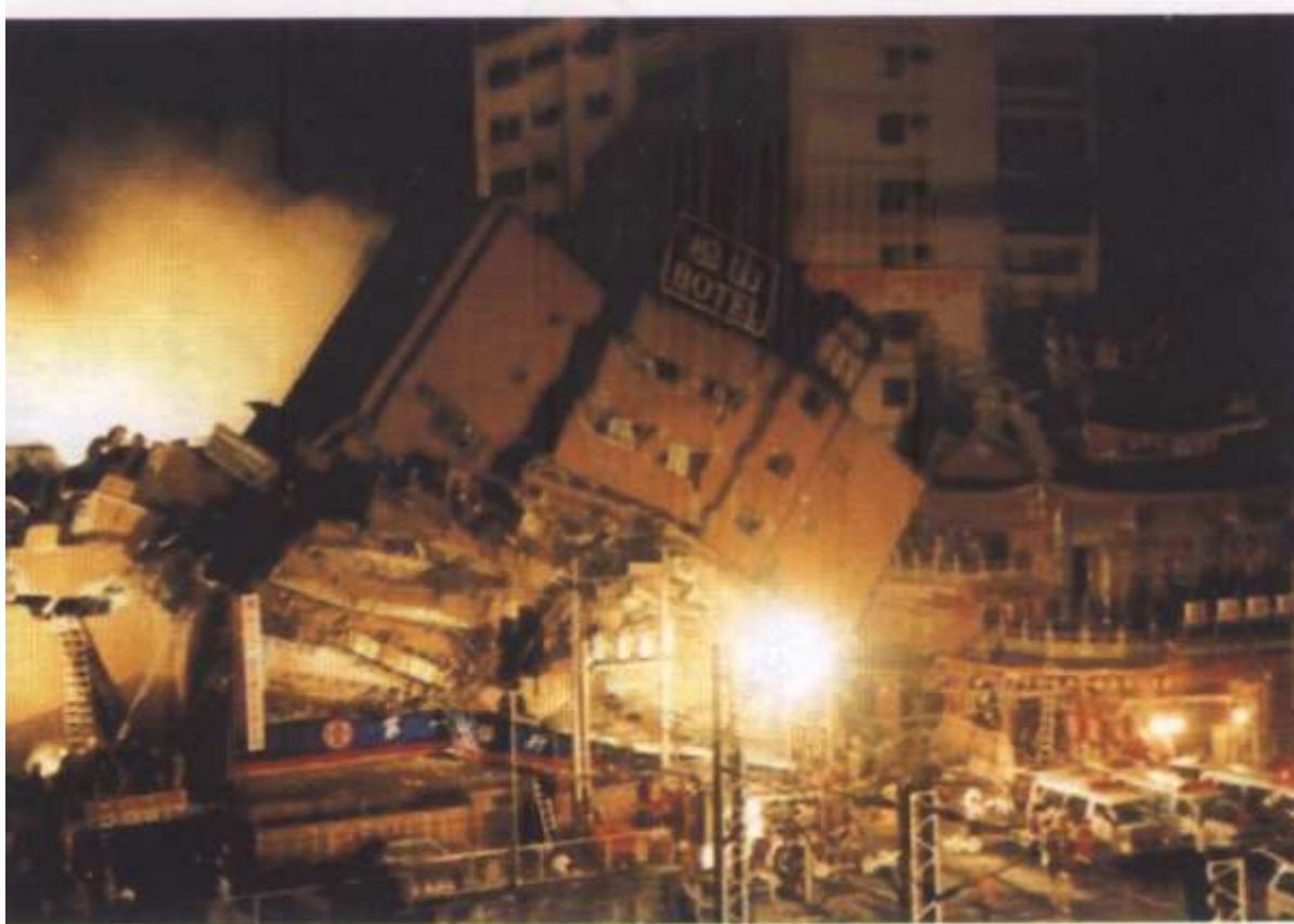
921集集地震引起之火災 （台北東興大樓） （土木工程技術地震叢書III）
