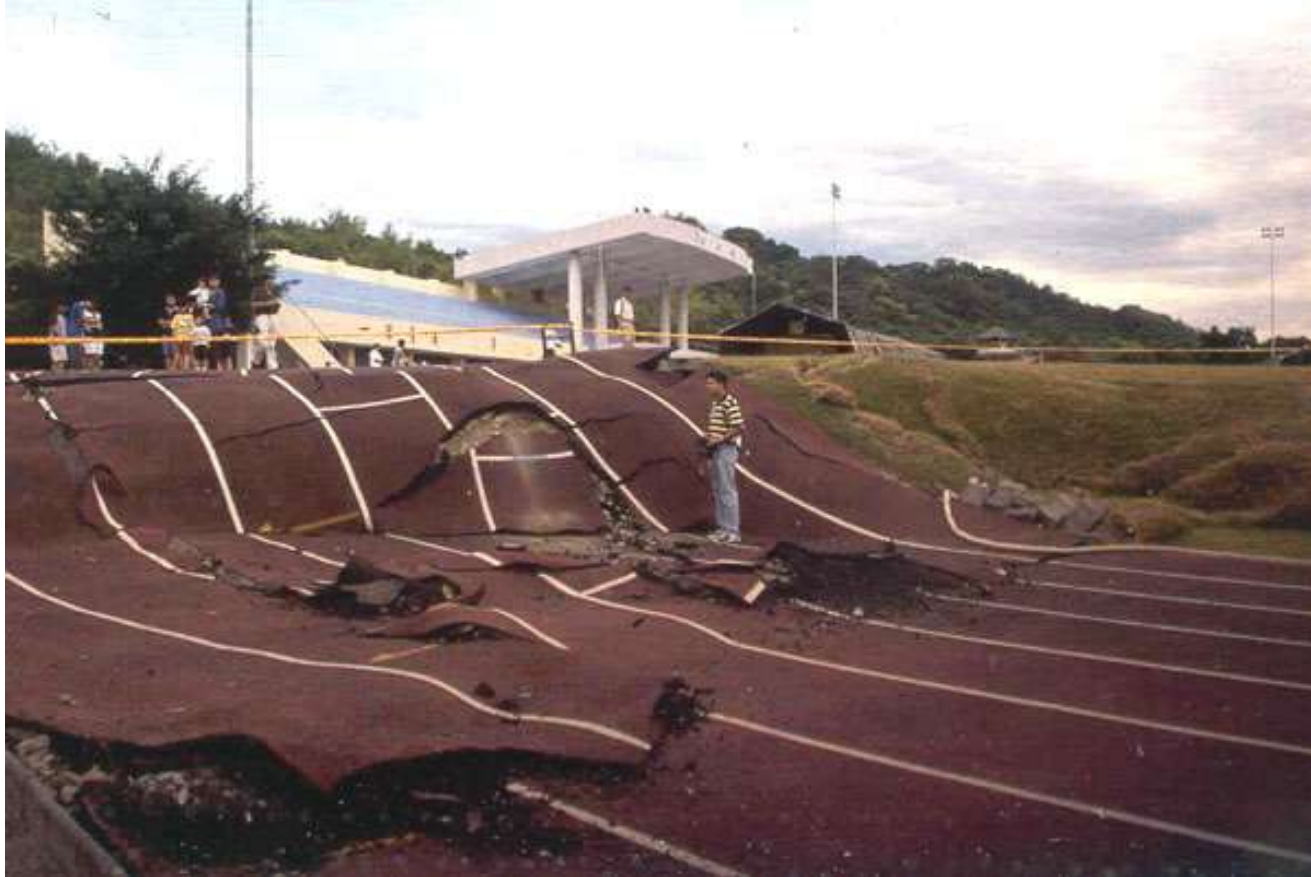
921集集地震引起之光復國中地表隆起扭曲破裂 (田永銘) (中央大學土木系)
