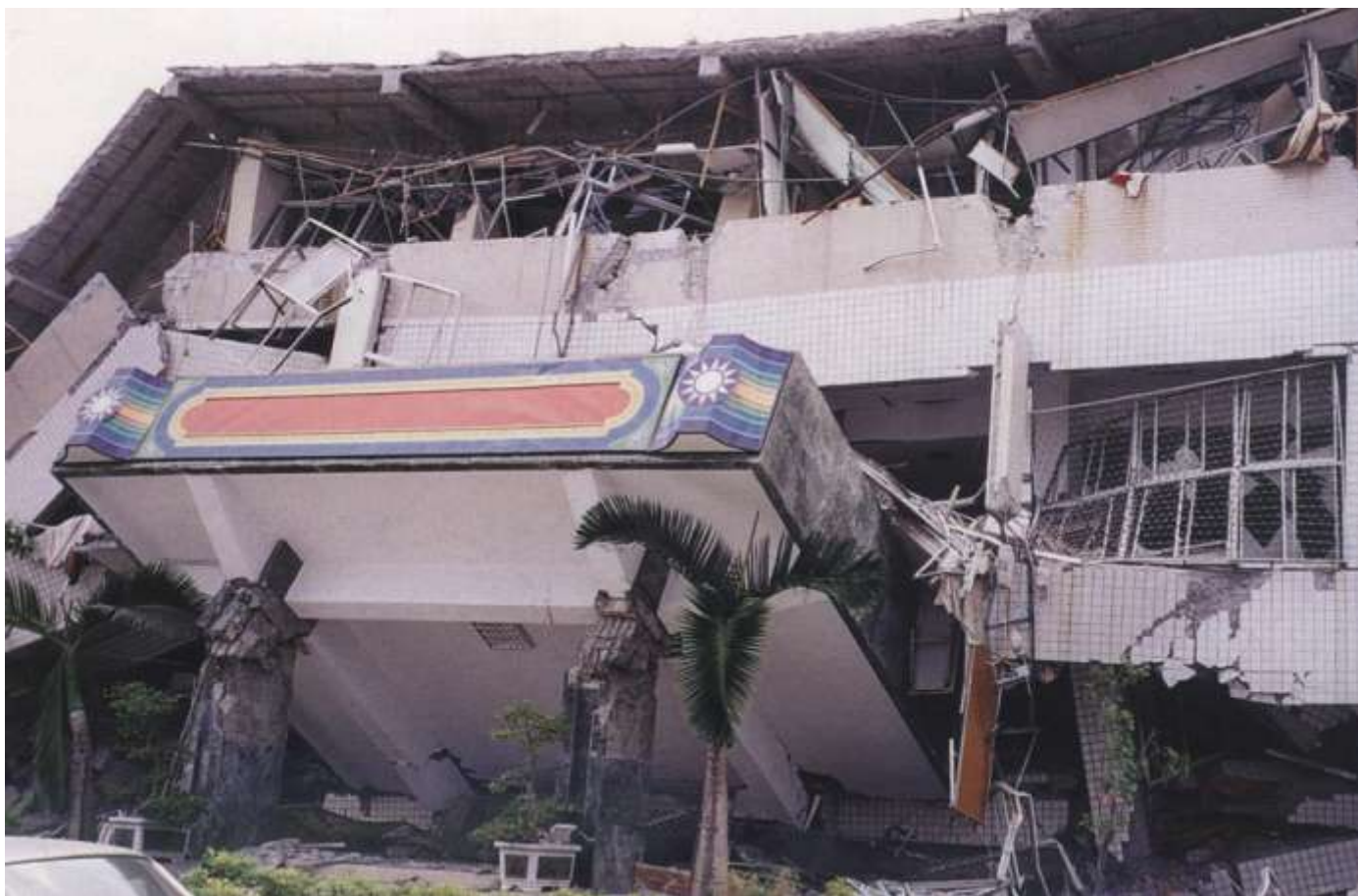
地震造成之房屋建築整棟崩塌災變 (土木工程技術地震叢書I)
