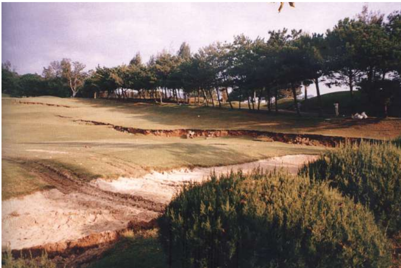
921集集地震引起之豐原市高爾夫球場地表破裂（張溢城）（土木工程技術地震叢書I）
