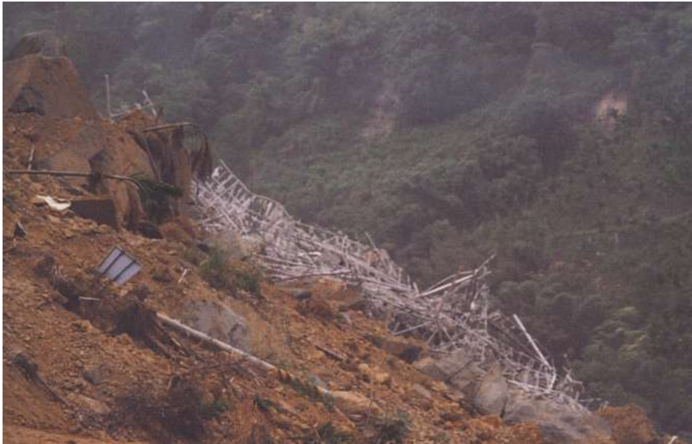
地震造成之輸電鐵塔設施倒塌災變照片 (土木工程技術地震叢書I)
