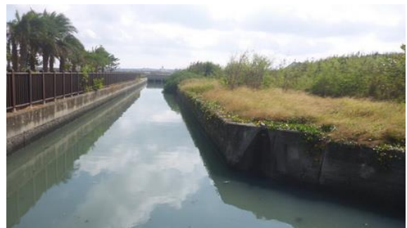
西衛公園旁區域排水
