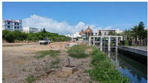
照片 2 西衛污水處理廠施工階段環境照片
