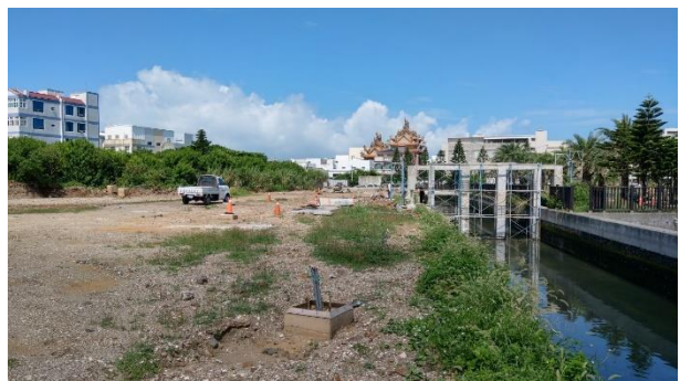
照片 2-2 西衛污水處理廠施工階段環境照片
