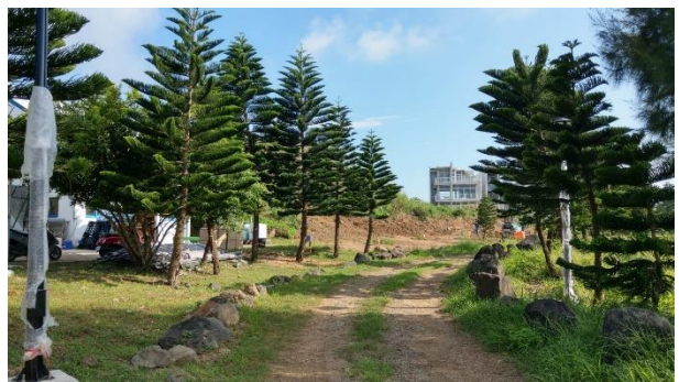
照片 2-6 山水污水處理廠施工階段環境照片
