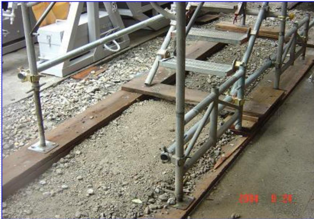
照片10 施工架底部之立架應設可調型基腳座板，基礎地面應平整、夯實緊密、襯以適當材質之墊材，以避免產生不均勻沉陷
