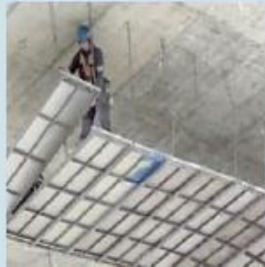
懸吊式施工架
