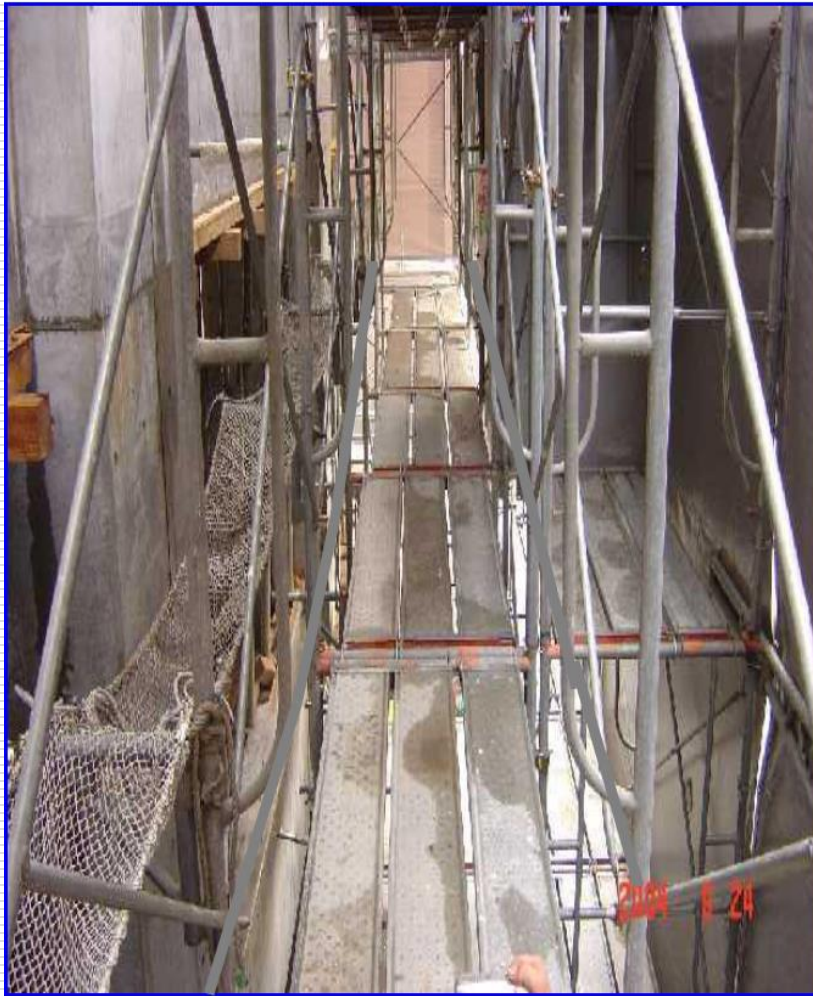
照片3 工作臺應鋪滿密接之踏板，施工架踏板間之縫隙應小於3公分
