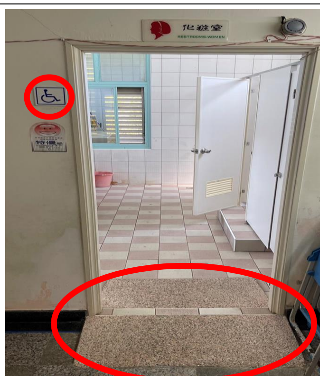
圖二：女廁（設有無障礙廁所標示與坡道）
