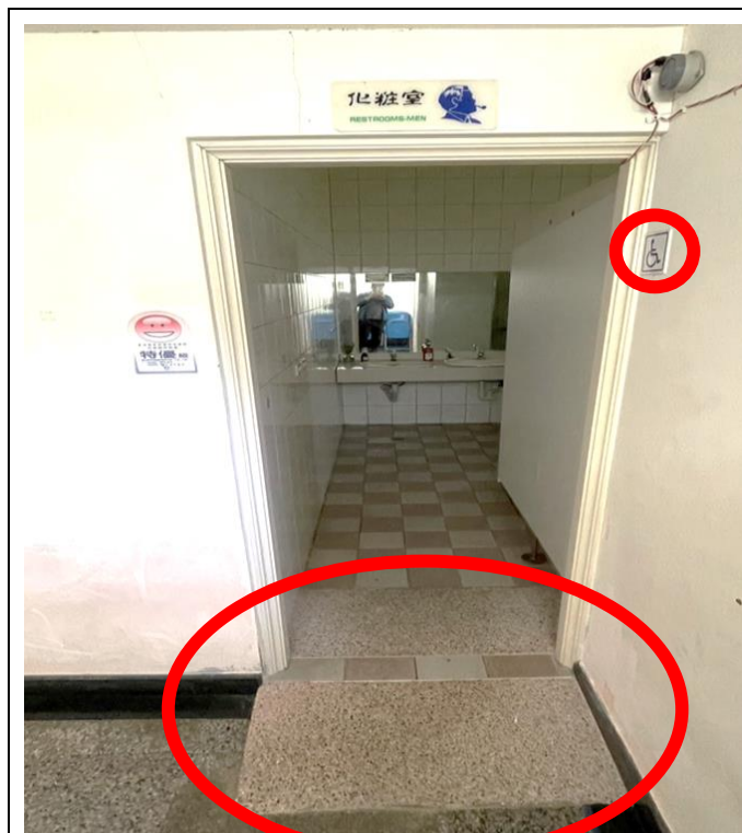
圖一：男廁（設有無障礙廁所標示與坡道）
