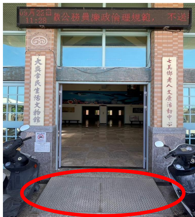
圖四：活動地點大門口（設有固定式緩坡）
