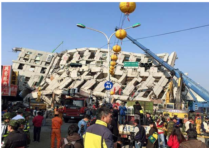
倒塌後--維冠金龍大樓南側
