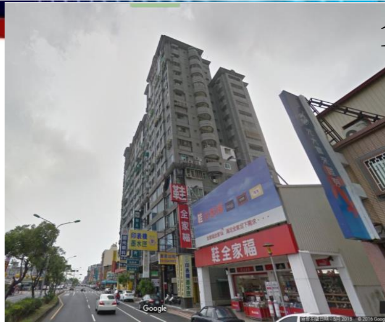
倒塌前--維冠金龍大樓北側
