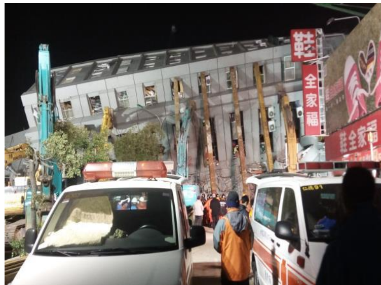
倒塌後--維冠金龍大樓北側
