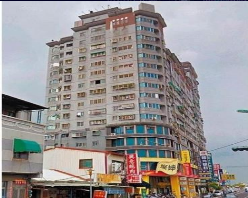
倒塌前--維冠金龍大樓南側
