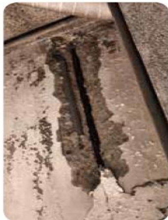
混凝土剝落
