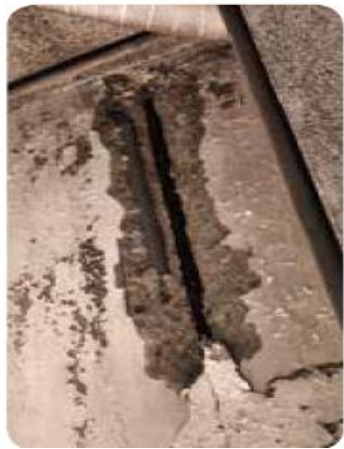
混凝土剝落
