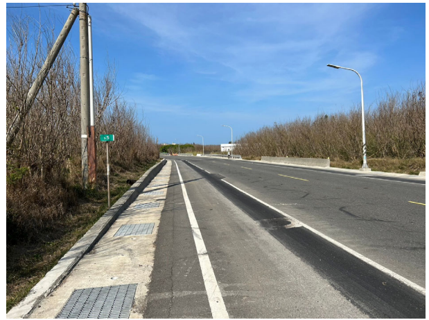
第 5 區(紅羅越域引水區(澎 13 道路)) 環境現況
