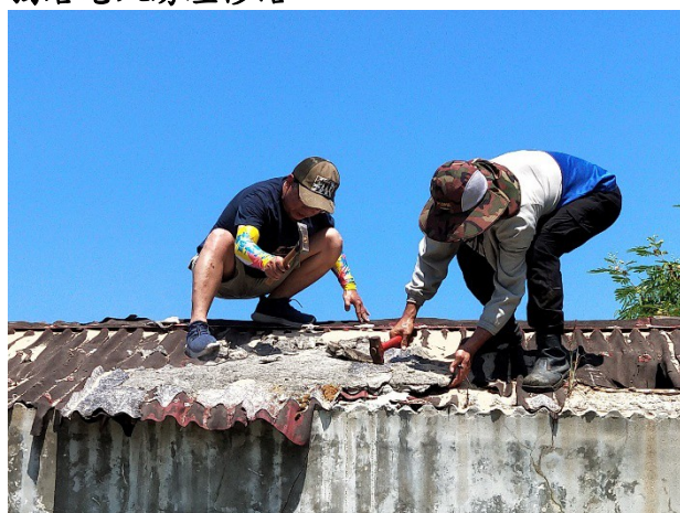
獨居老人房屋修繕
