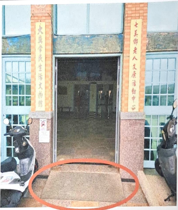
圖四：活動地點大門口（設有固定式緩坡）
