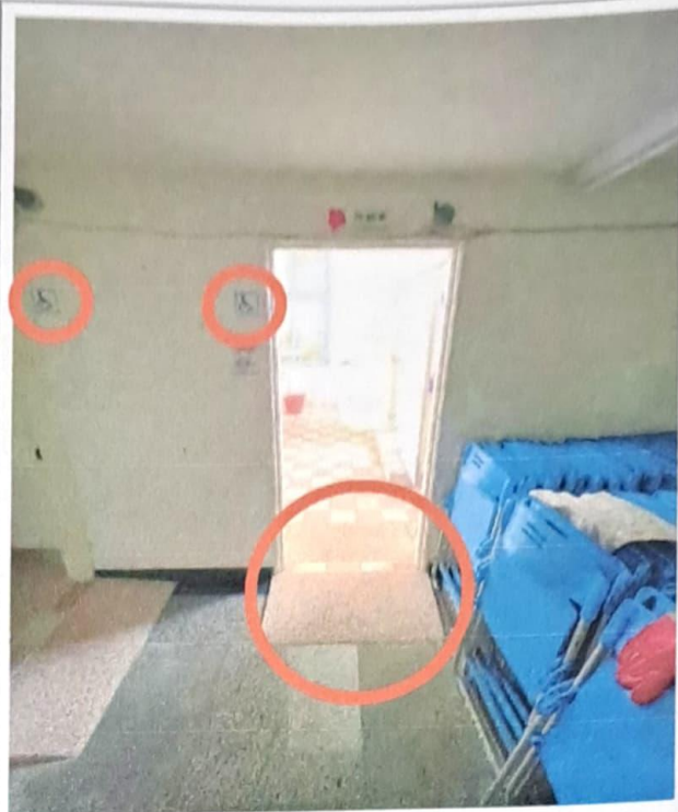
圖二：女廁（設有無障礙廁所標示與坡道）
