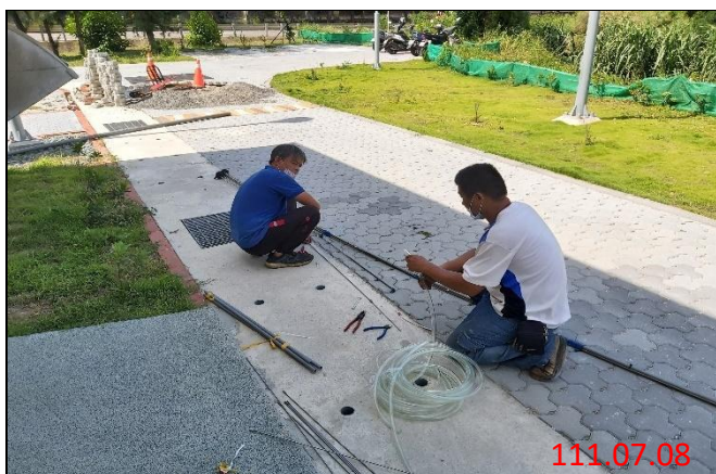
校正維護-放流電擊棒更換
