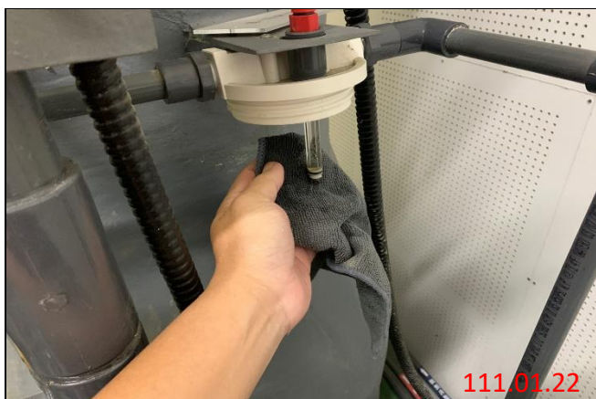
校正維護-除臭 sensor 校正
