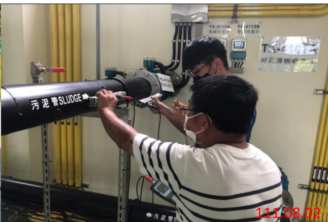
校正維護-流量計校正
