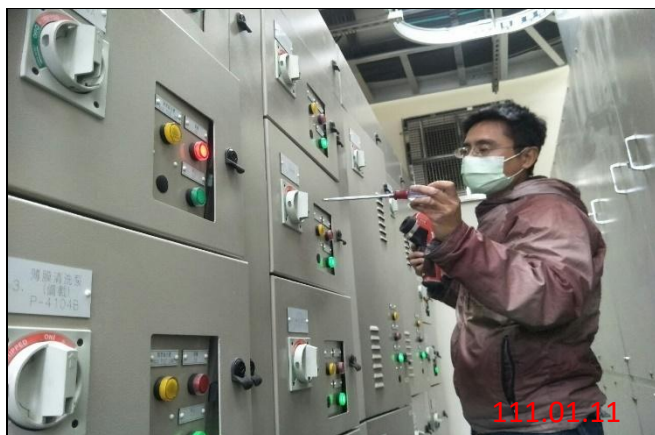
機電設備檢查
