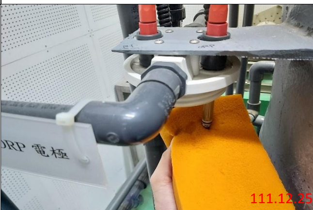
校正維護-除臭 sensor 校正及清洗
