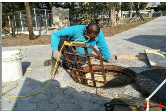
PD-01 人孔防水施工
