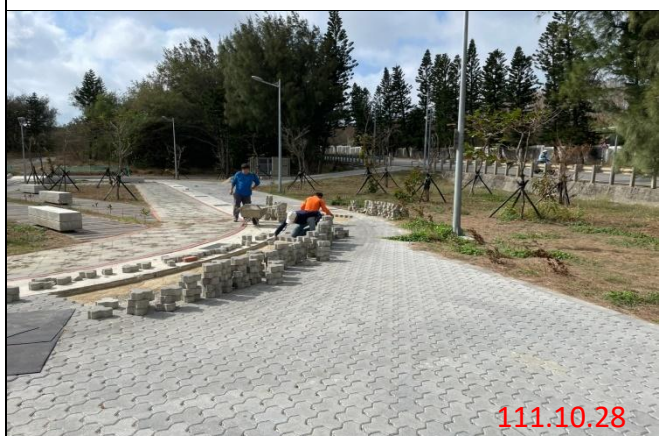
道路修補作業
