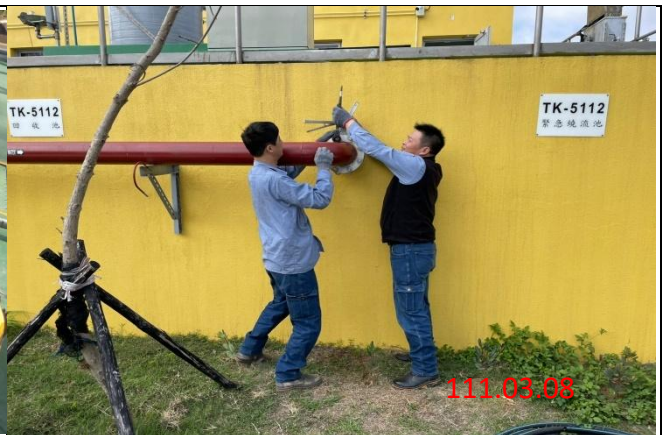
緊急繞流閥蝶閥&蝶閥鎖施工作業
