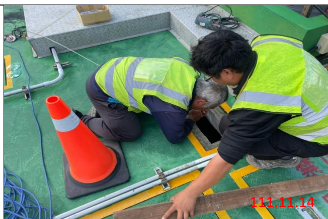
放流水池水閘門修改
