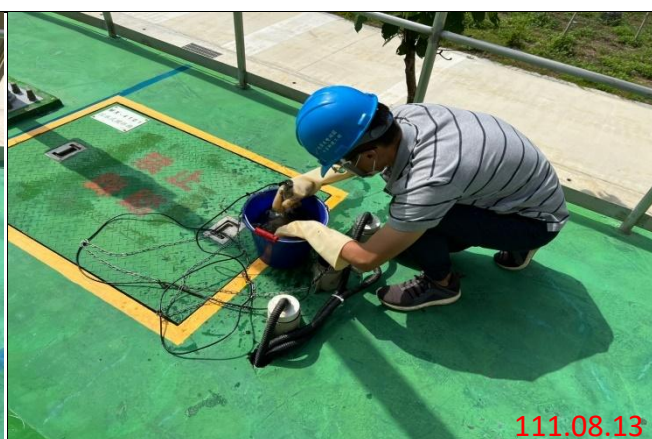
一般維護-儀表 sensor 清洗維護
