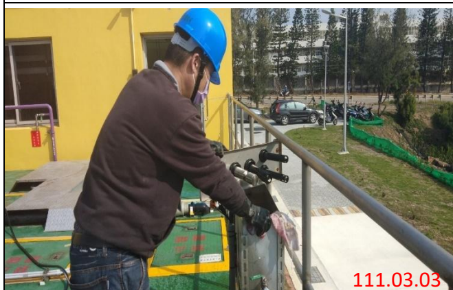
一般維護-放流水水質監測水槽清洗
