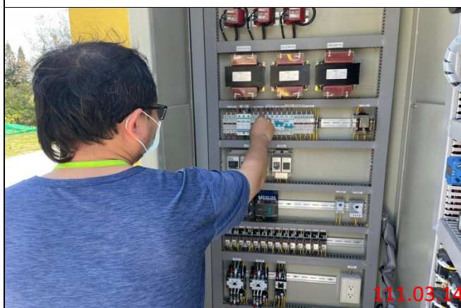
校正維護-UCP5113 電盤更換保險絲
