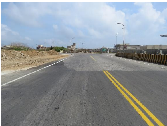
施工便道使用既有道路
