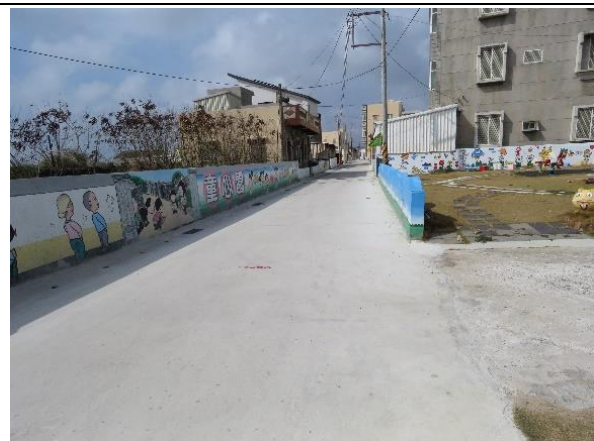
工區內未遺留人為或工程廢棄物
