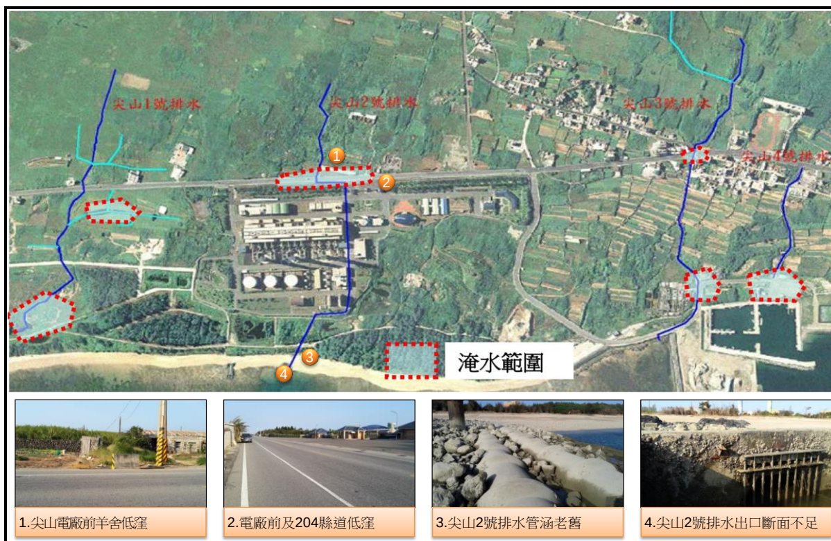
圖1-2 計畫區淹水範圍及排水路現況
