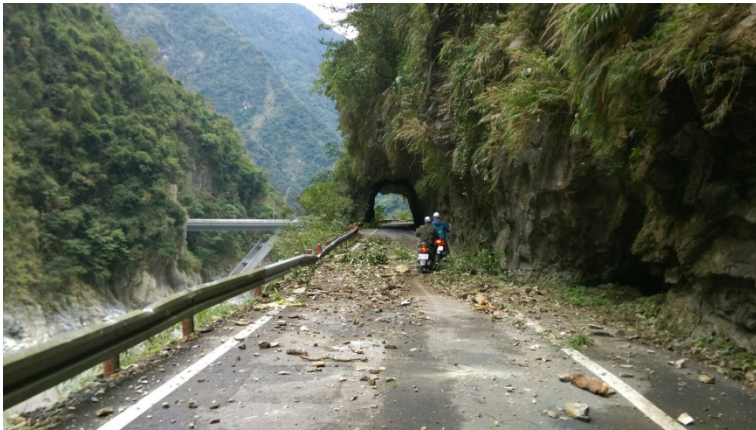
長春祠東側舊路土石崩塌
