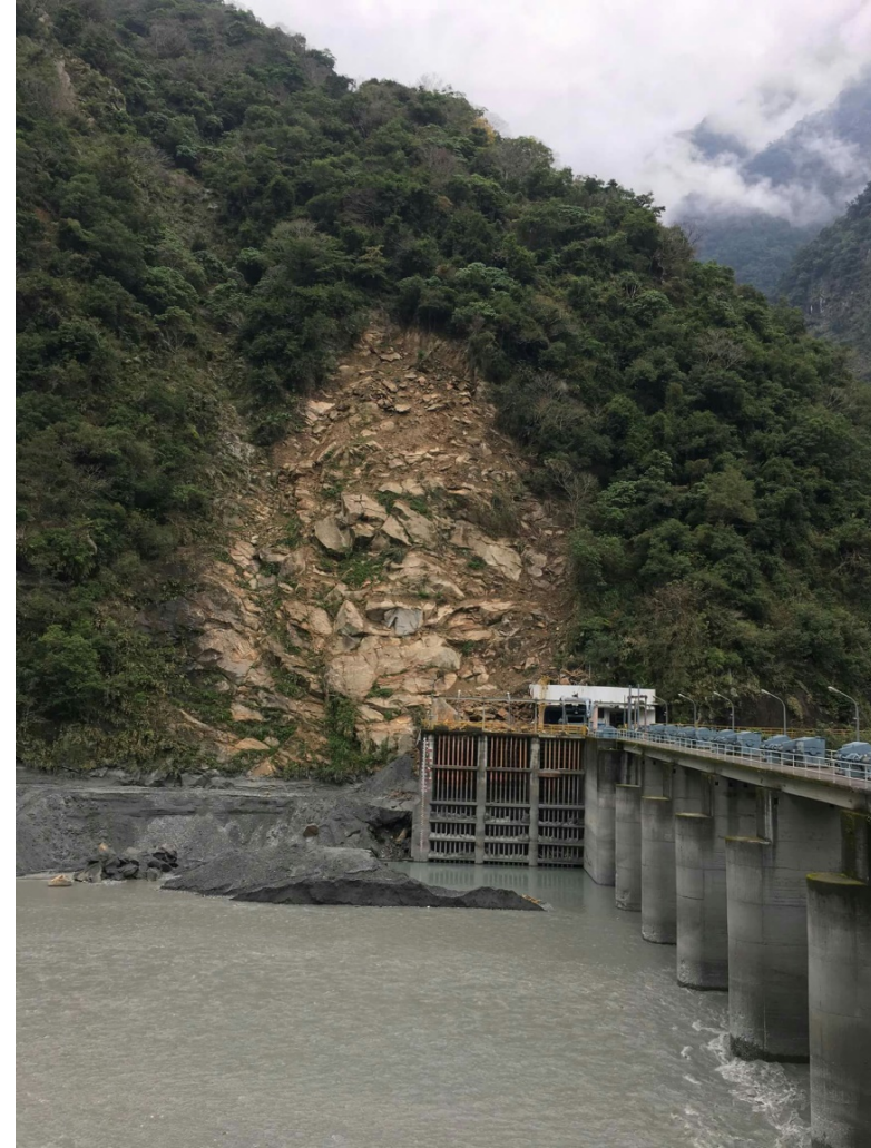
太魯閣溪畔壩土石崩落
