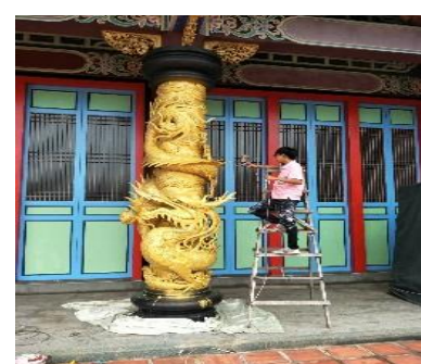
大成殿前龍柱施作過程
