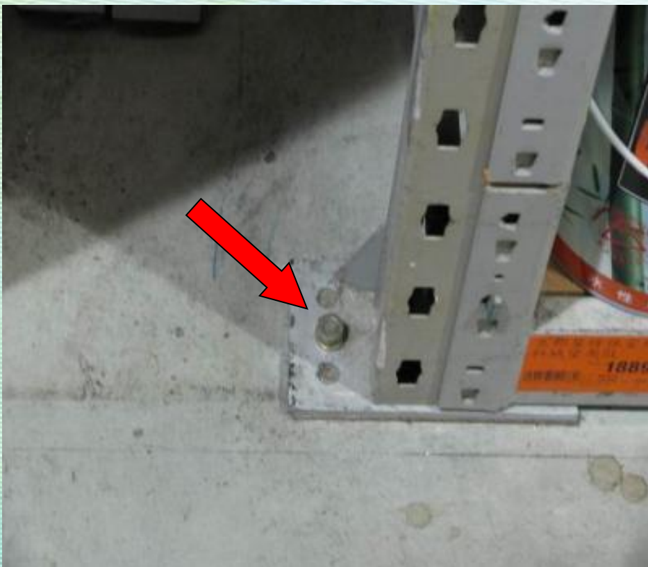
貨物架基底固樁 與防護掉落之措施
