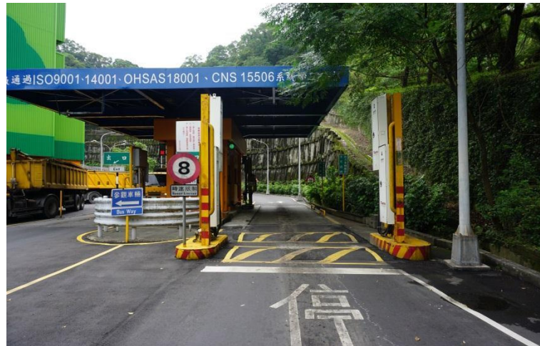
垃圾焚化廠之門框式輻射偵檢器
