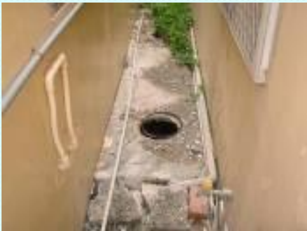
開放式排水溝
