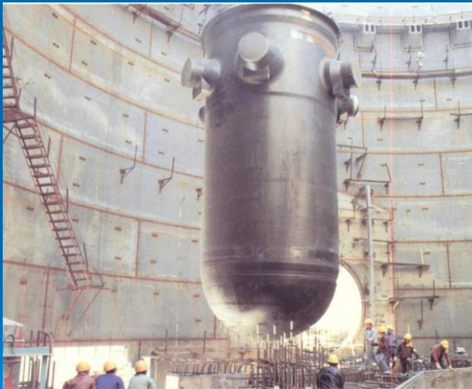
反應爐壓力槽、圍阻體，以及燃料棒護套、屏蔽牆等，構成了核能電廠的多重蔽障。(臺電公司提供)
