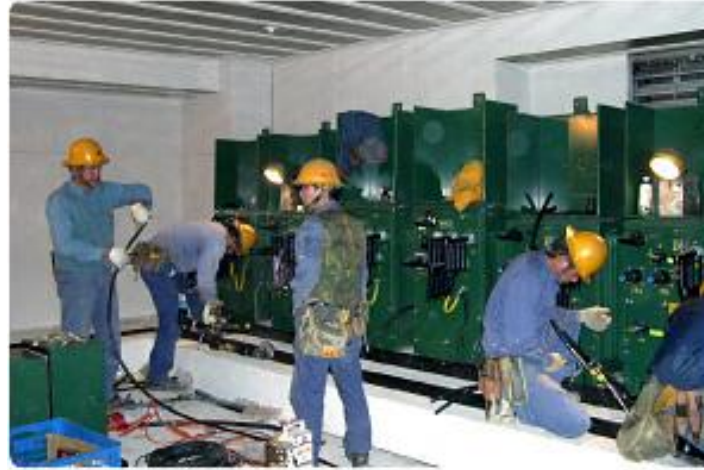
代辦升壓變壓器
