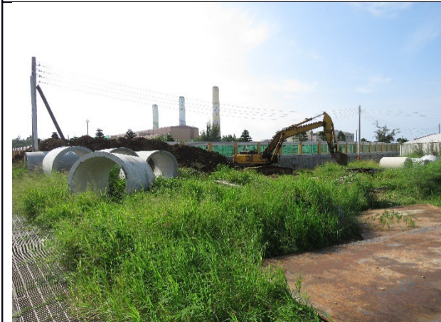
工區內減少移除植被
