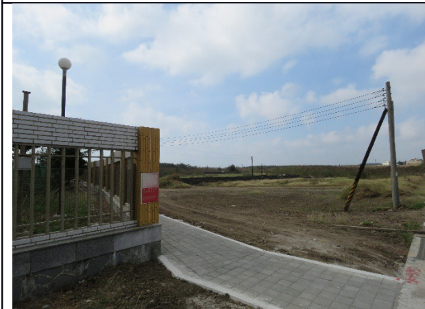
土砂堆置區已復原
