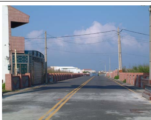
照片 2：可見道路兩側住宅區側多未開闢
