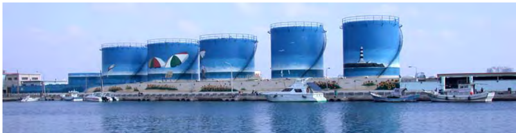
第一漁港儲油槽景觀現況
