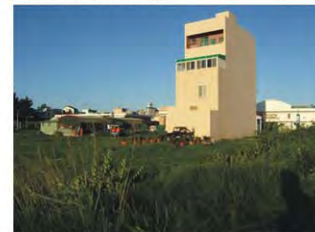
商1用地上建物及鐵皮設施
