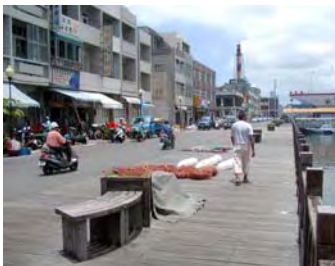
第二漁港公共設施現況
