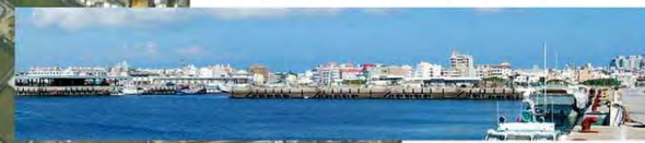
10. 第三漁港東岸港區及都市景觀現況
