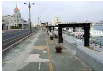
第三漁港浮動碼頭現況
