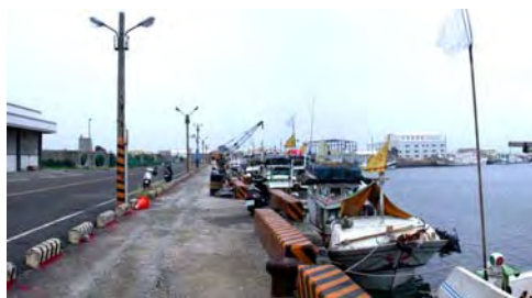
第三漁港東側碼頭現況
