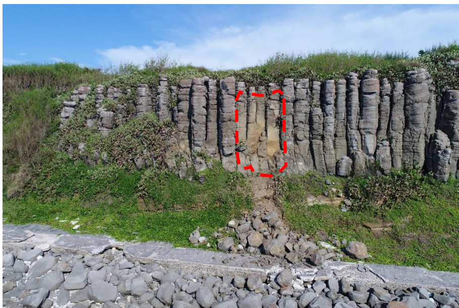
圖 32 8 月一場強降雨後發生的崩塌，紅色框為崩塌的範圍
