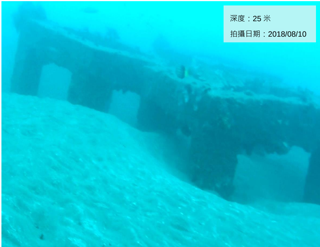
圖 20 鎖港魚礁區方塊礁排列較為零散
