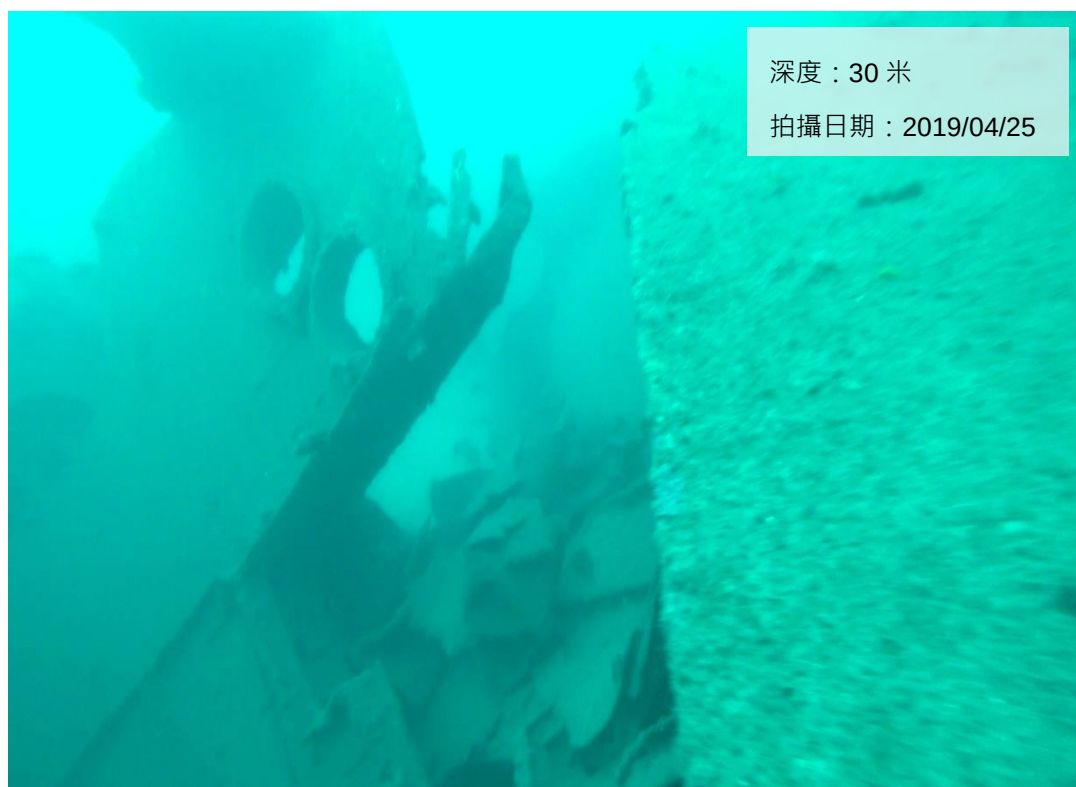
圖 27 錠鉤嶼魚礁區船礁甲板處有輕微破碎扭曲的問題
