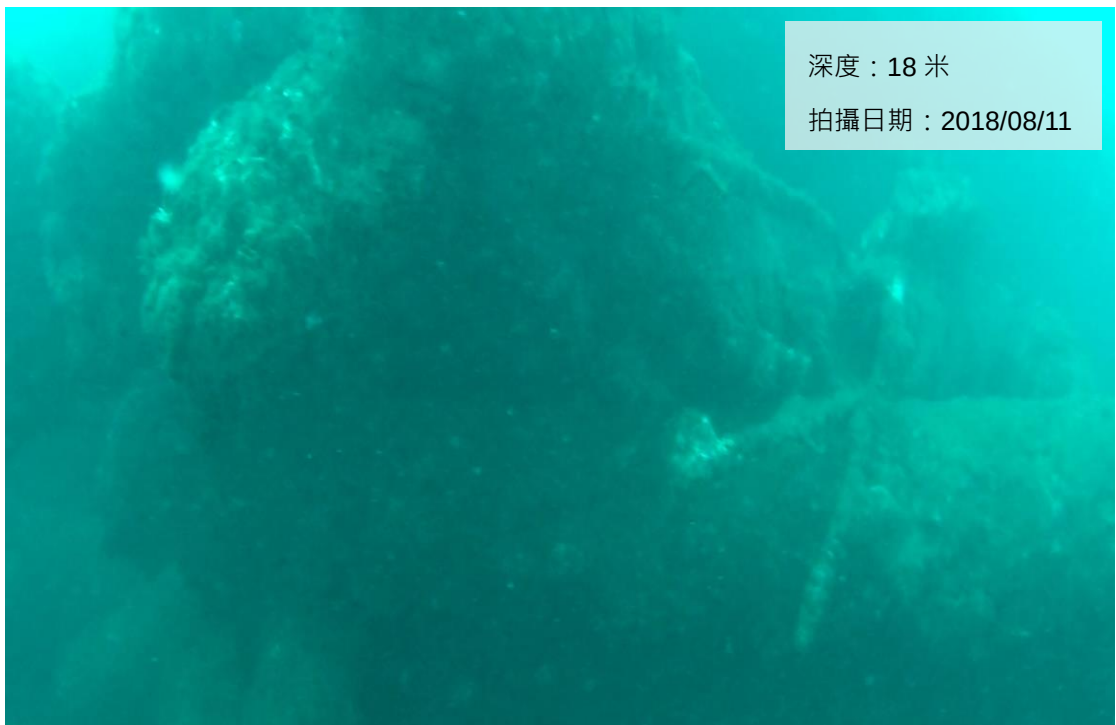
圖 23 香爐嶼魚礁區電桿礁體出現輕微的破損
