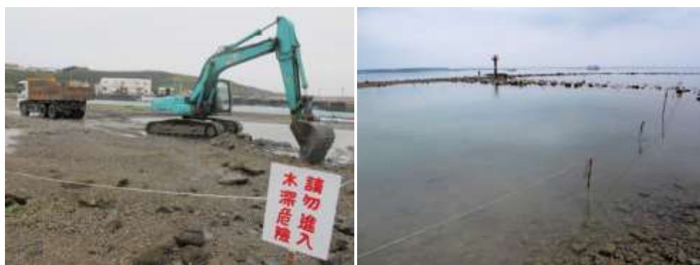
圖 15. 退潮期間使用怪手進行劣化基質移除作業可降低對環境的衝擊。
