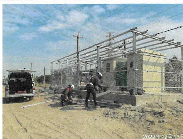
太陽能併網升壓站施工情形
