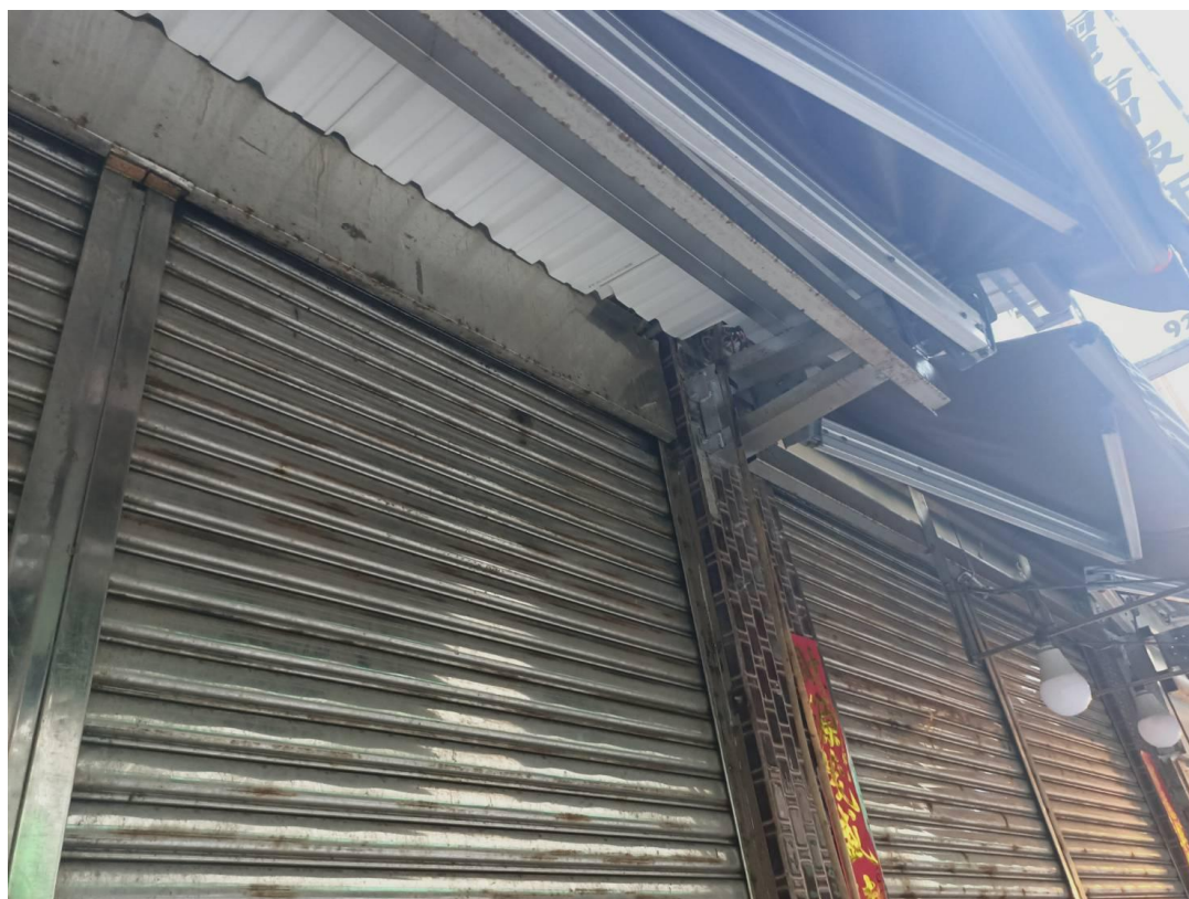
說明：鐵捲門兩側骨架固定照片(上圖)、鐵捲門上方固定照片(下圖)
