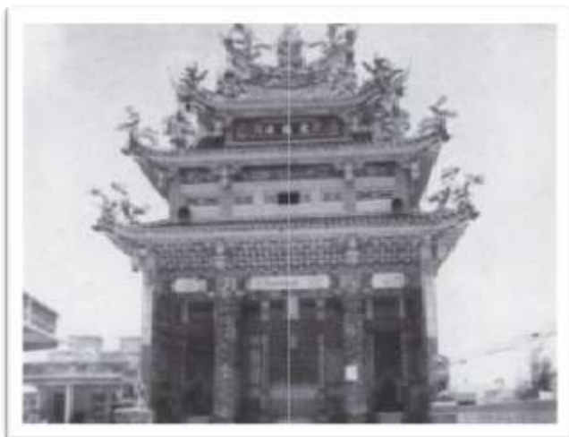
民國 68 年重建的鎖港北極殿
