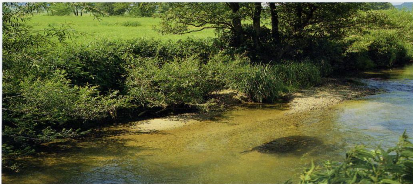
ヤナギの灌木を用いた生態土工法による岸辺の安全確保
