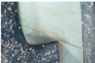
爐足與爐身接合處
