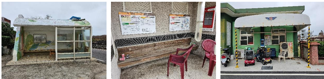
圖 4.1-5 候車亭內候車座椅概況
