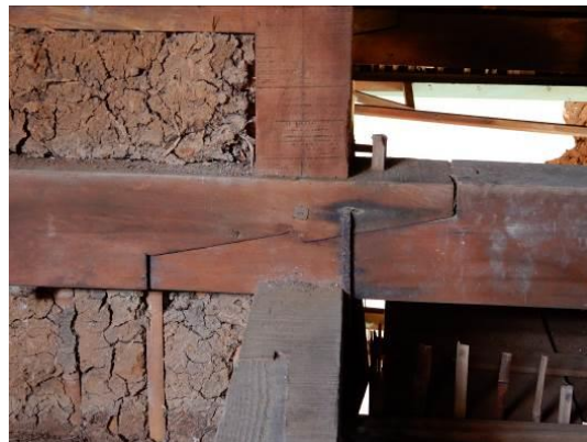
圖 49 和小屋組陸梁之樁接方式
