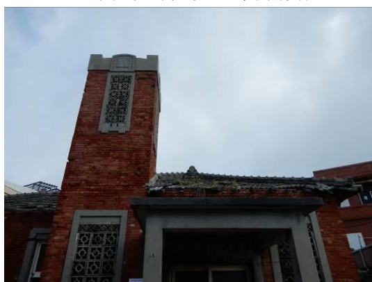
圖 7 塔樓南向正立面
