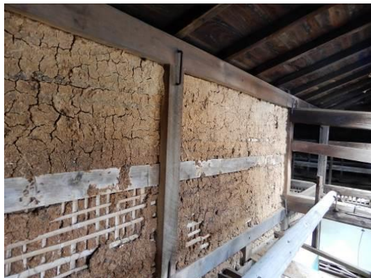
圖 48 台所之編竹夾泥牆（小舞壁）施作至桁木處
