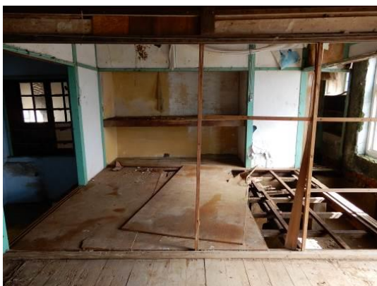
圖 27 床板構造
