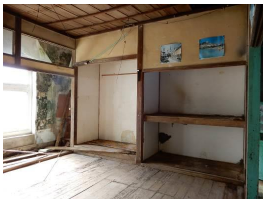
圖 38 完整之編竹夾泥牆 (小舞壁)
