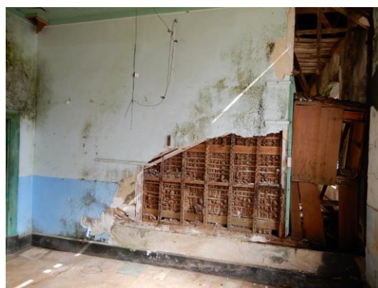
圖 39 辦公廳之木榴壁與編竹夾泥牆 (小舞壁) 混合
