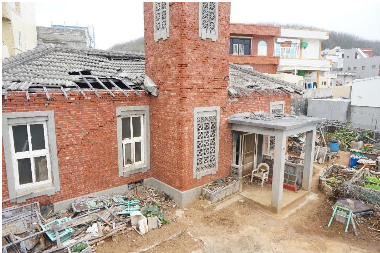
附圖 2-1 視署南向立面現況
