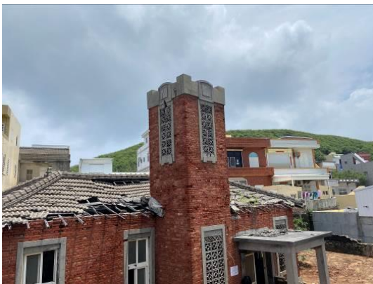
圖 54 南側正面屋頂
