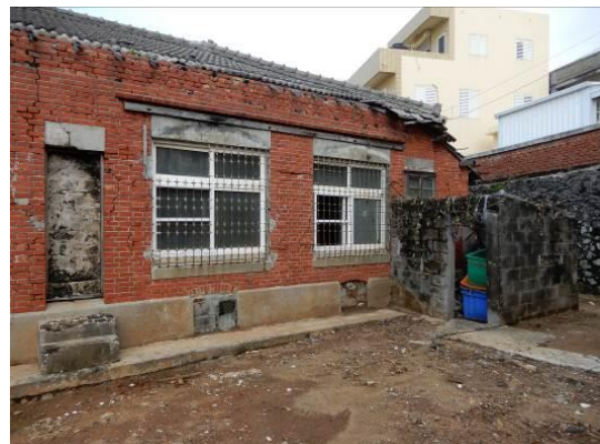
圖 23 東側立面牆基 ( 布基礎 ) 及通氣孔
