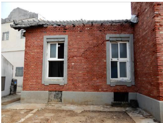
圖 22 南側正立面牆基 ( 布基礎 ) 及通氣孔
