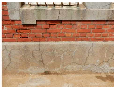
洗石子基牆粉刷層龜裂
