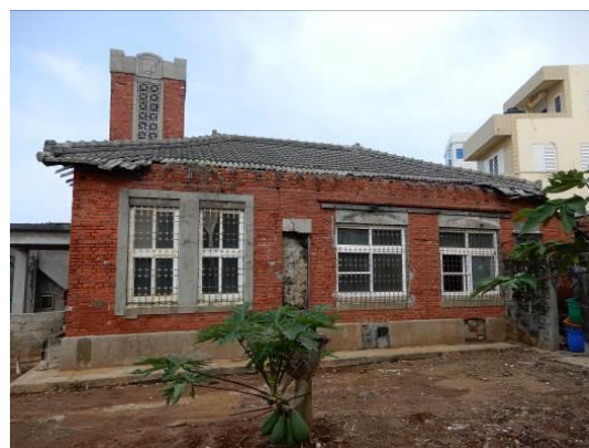
圖 10 主體建築東向側立面
