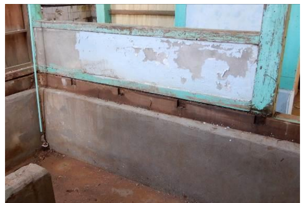
圖 28 放置根太之樁孔
