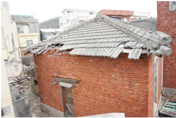
附圖 2- 2 視署西向立面現況
