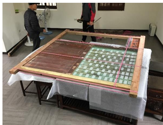
照片 76 另一面壁板加固情形
