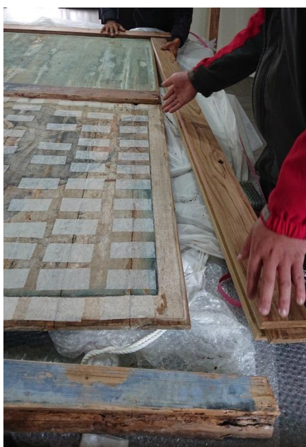
照片 69. B 邊樺接處以刷具清除泥土及髒汙
