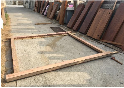
照片 63. 試組裝情形
