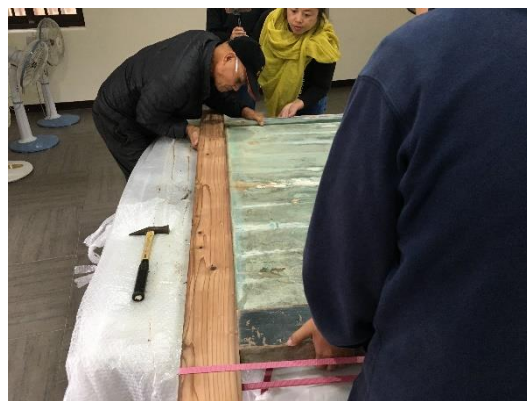
照片 68. 再慢慢調整樺接處與壁板
