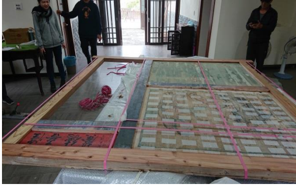
照片 79. 木框替換完成
