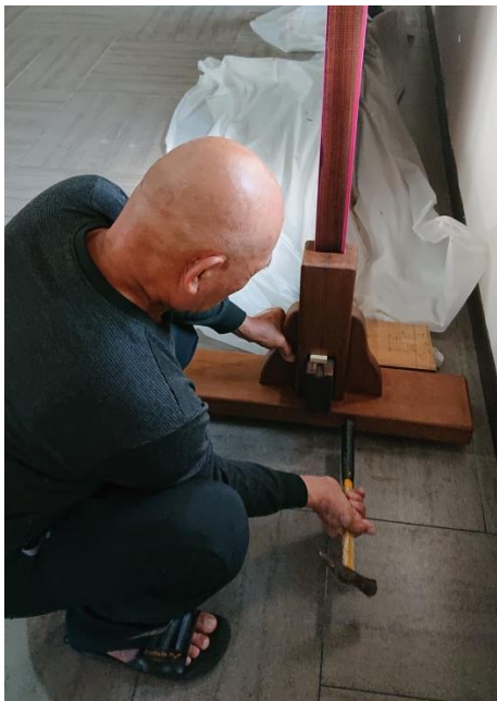
照片. 118 底座施工過程
