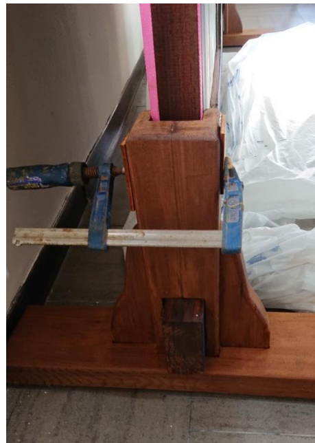
照片 119. 底座施工過程
