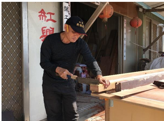
照片 57. 根據畫線處鋸出樺頭
