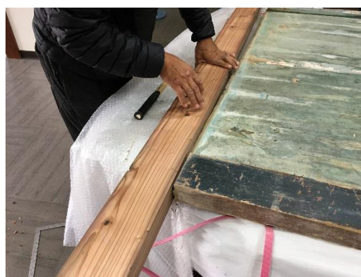
照片 66. 替換新木框條
